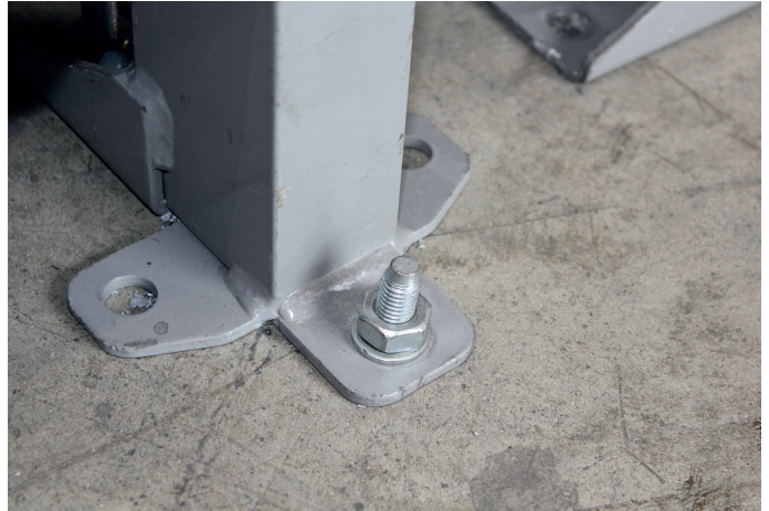
Fixation d'un pied de poteau sur dalle béton avec goujon d'ancrage MTH.
