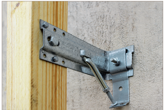
Fixation d'une équerre de bardage avec goujon d'ancrage MTP.
