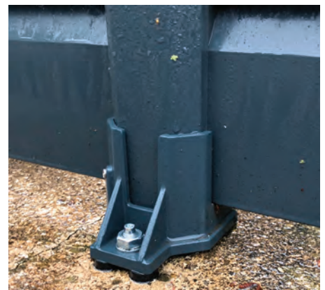
Fixation d'une platine de palissade sur béton.
