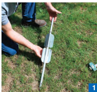
Mise en place de la croix.
