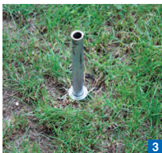
Déploiement des tiges à l'aide du mandrin et de la plaque fendue.
