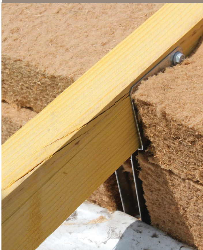
Performance Thermo-Acoustique (Plusieurs couches croisées d'isolants)
