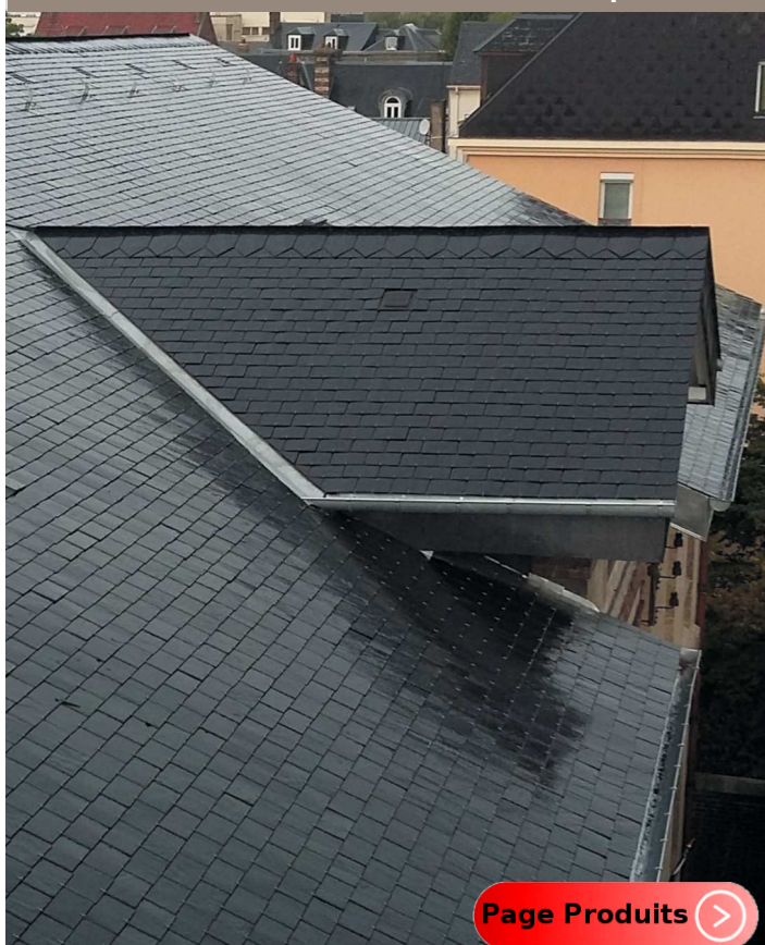
Traitement des points singuliers (chevêtres, arêtiers et noues à l'identique)
