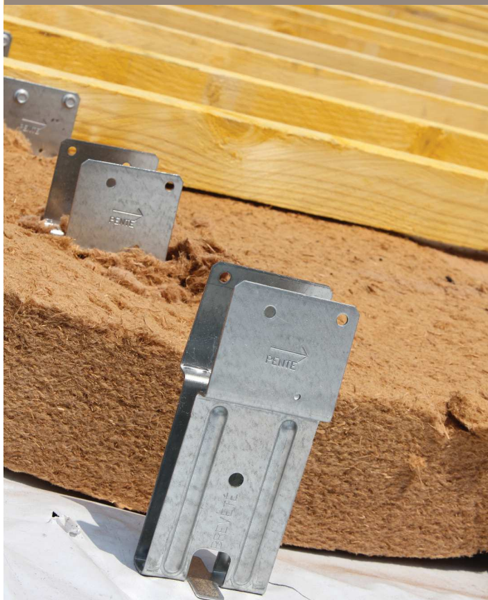
Mise en œuvre traditionnelle (pour tout type d'isolants)
