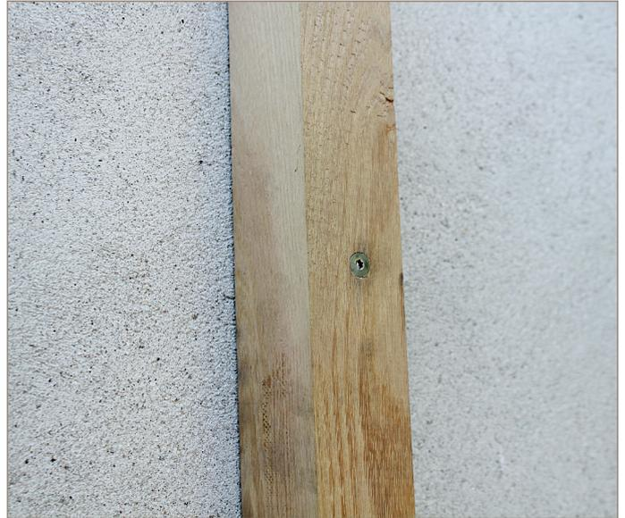
Fixation d'un chevron sur mur avec vis tête fraisée et cheville plastique.
