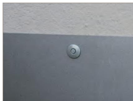
Tôle plane prélaquée sur maçonnerie.
