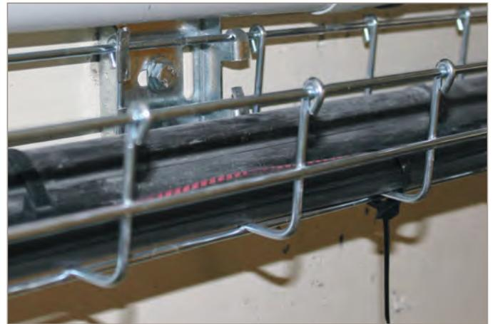
Fixation d'un chemin de câbles avec cheville métallique.
