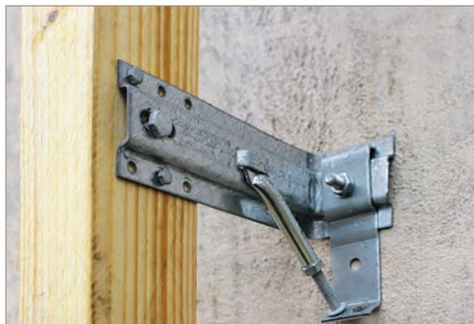
Fixation d'une équerre de bardage avec goujon d'ancrage F-MTP.
