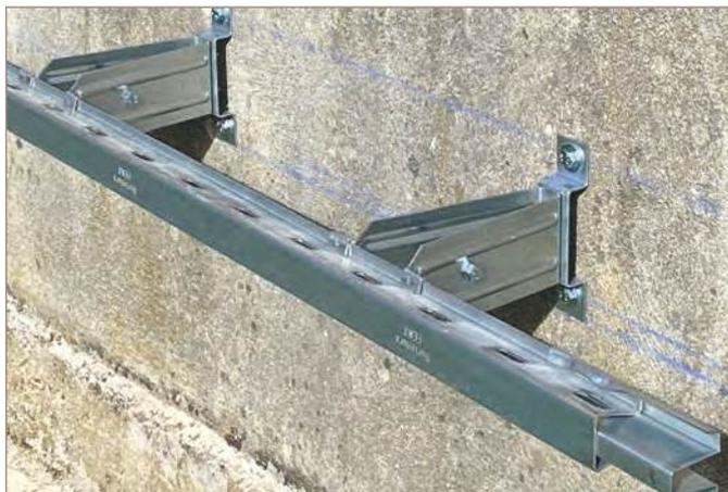
Fixation d'une ossature secondaire sur mur en parpaing enduit.
