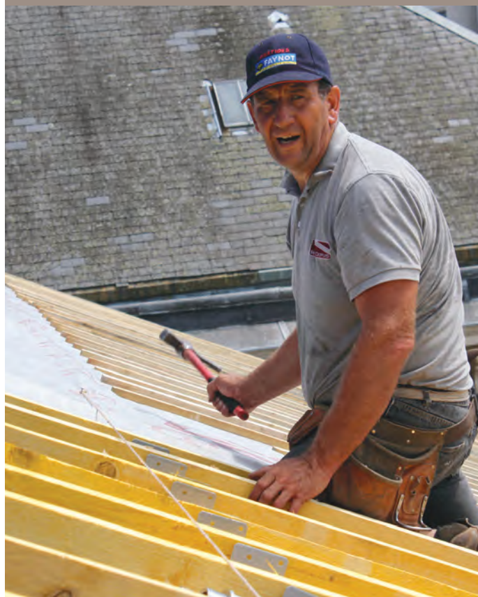
Réglage aisé du plan de couverture (possibilité de réglage jusqu'à 40 mm sans calage)
