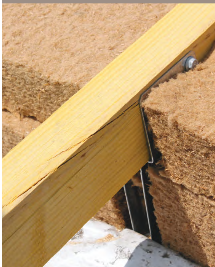
Performance Thermo-Acoustique (Plusieurs couches croisées d'isolants)
