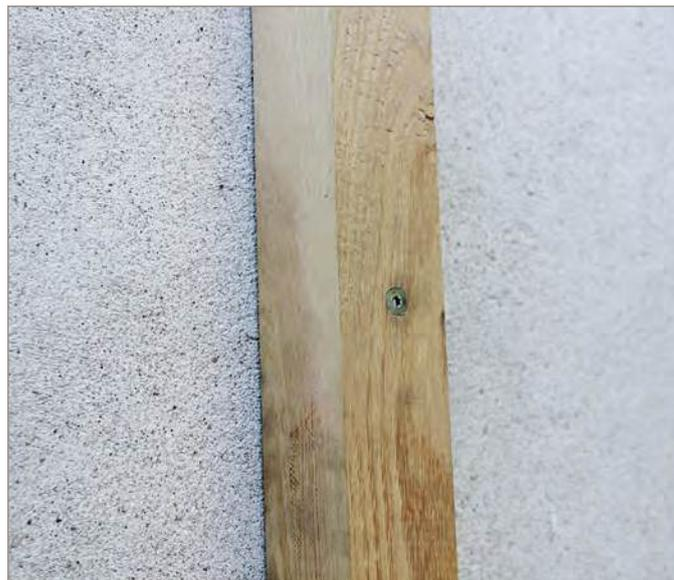
Fixation d'un chevron sur mur avec vis tête fraisée et cheville plastique.
