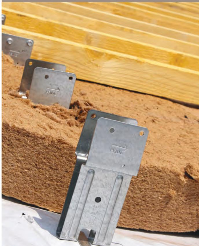
Réglage aisé du plan de couverture
