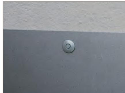
Tôle plane prélaquée sur maçonnerie.
