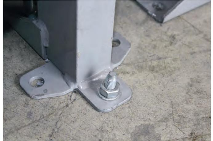
Fixation d'un pied de poteau sur dalle béton avec goujon d'ancrage F-MTH.
