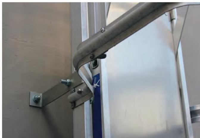
Fixation d'une échelle à crinoline sur mur béton avec goujon d'ancrage F-MTH-A4.
