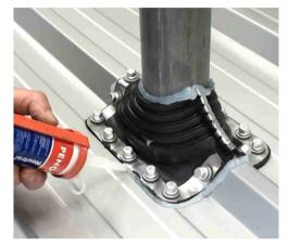
Finaliser l'étanchéité en appliquant un cordon de mastic sur le contour de l'embase du manchon, ainsi qu'au niveau du tuyau et bride.
