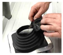
Choisir le manchon adapté au diamètre du tuyau. Découper soigneusement à un diamètre inférieur de 20% à celui du tuyau.
