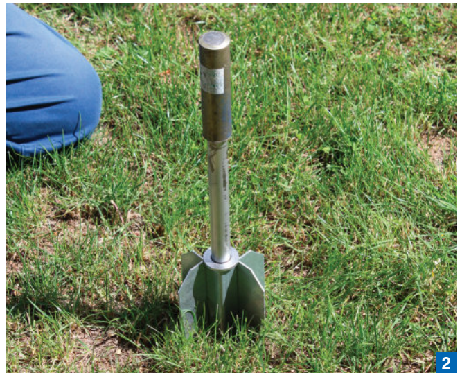
Enfoncement de l'amarre à l'aide de l'outil d'enfoncement.
