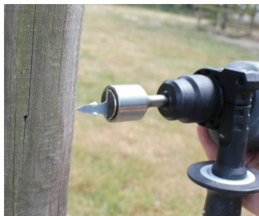
Pose de la pointe barrette avec l'outil cloueur.
