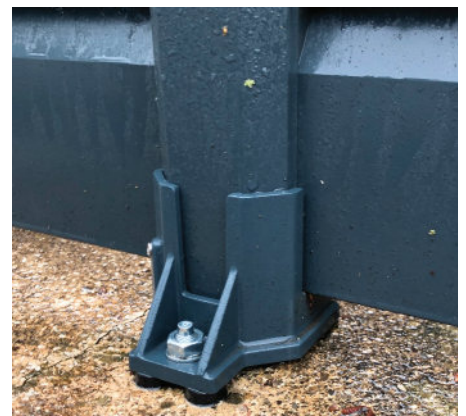
Fixation d'une platine de palissade sur béton.
