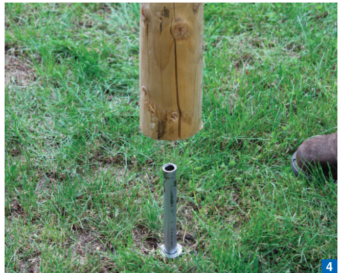
Emmanchement du piquet bois sur l'amarre.
