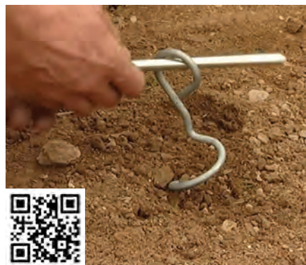
Mise en place de l'ancrage tire-bouchon. Scanner pour visionner la vidéo.
