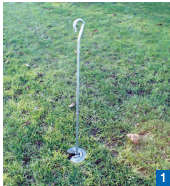
1 Monter la tige et le disque puis commencer à visser l'ancrage dans le sol.
